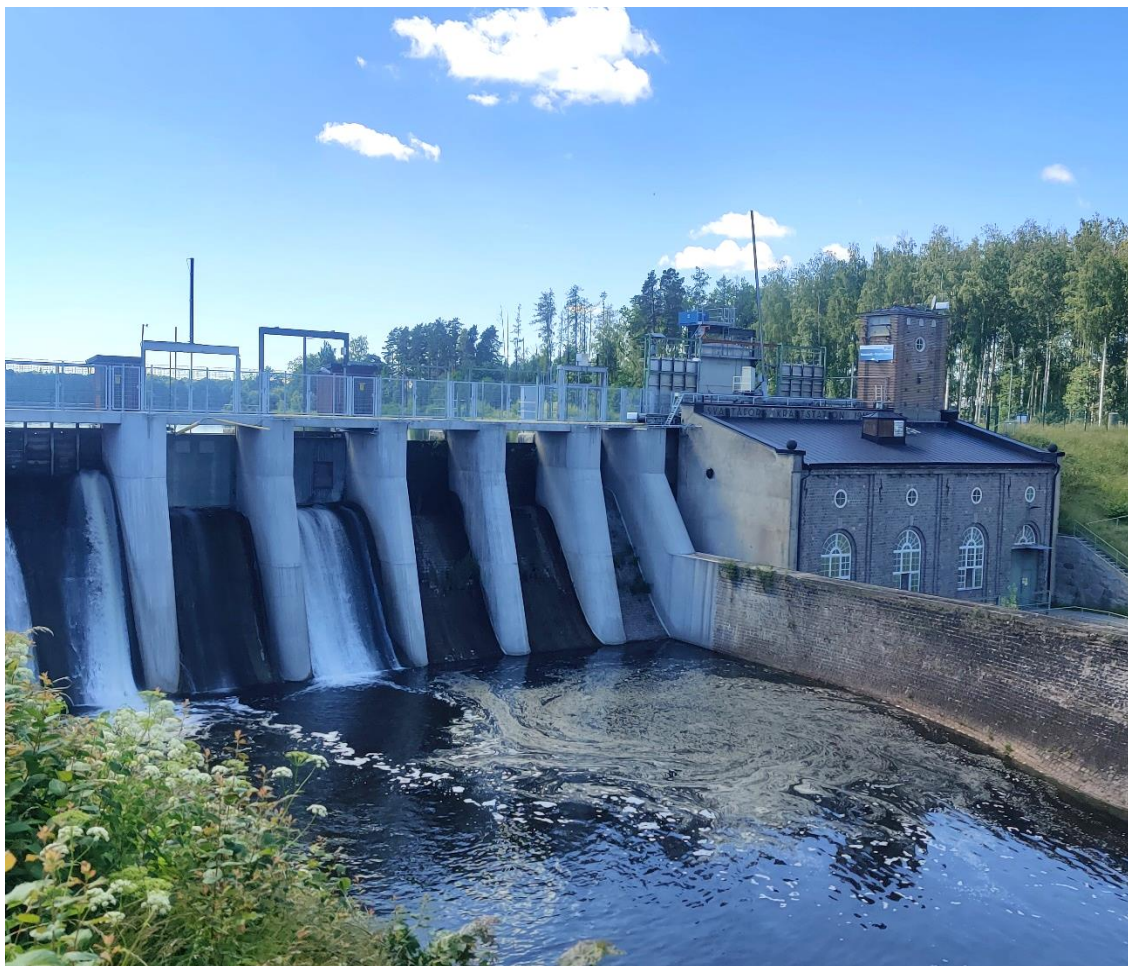
Svartåfors vattenkraftverk , nordväst om Linköping, strax före Svartåns mynning i Roxen är ett av flera vattenkraftverk i Svartån. Foto: Svartån-Sommens Vattenråd.
