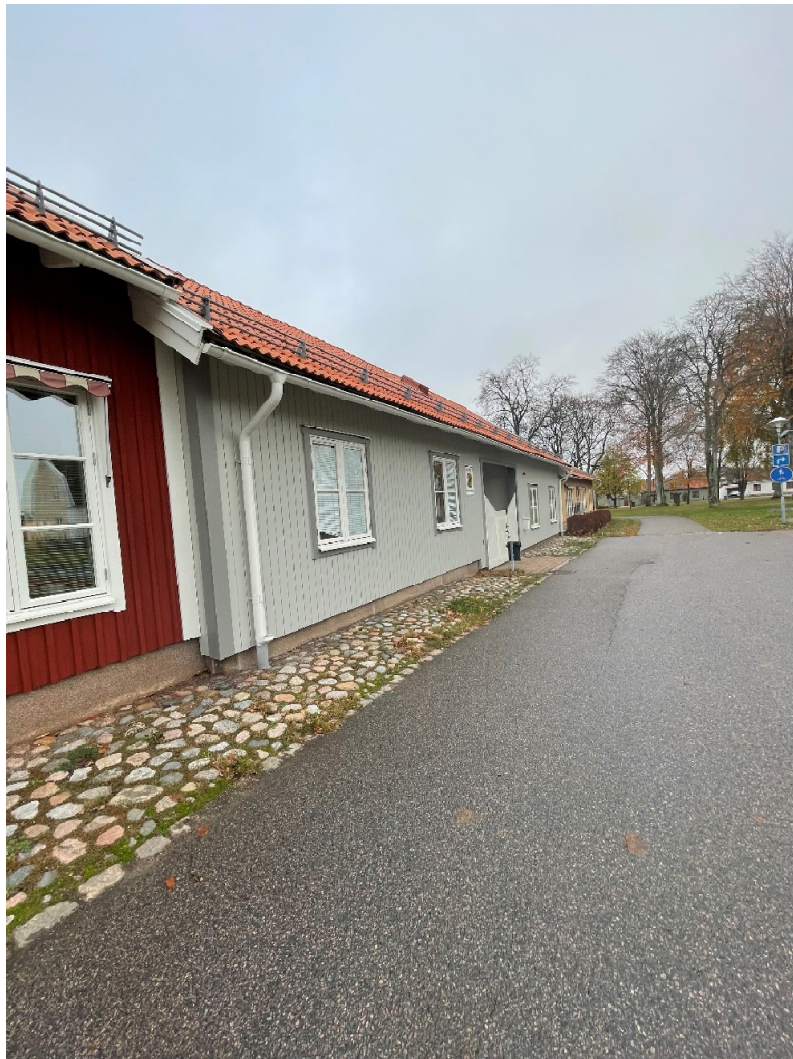
Figur 2, Fasad mot söder
