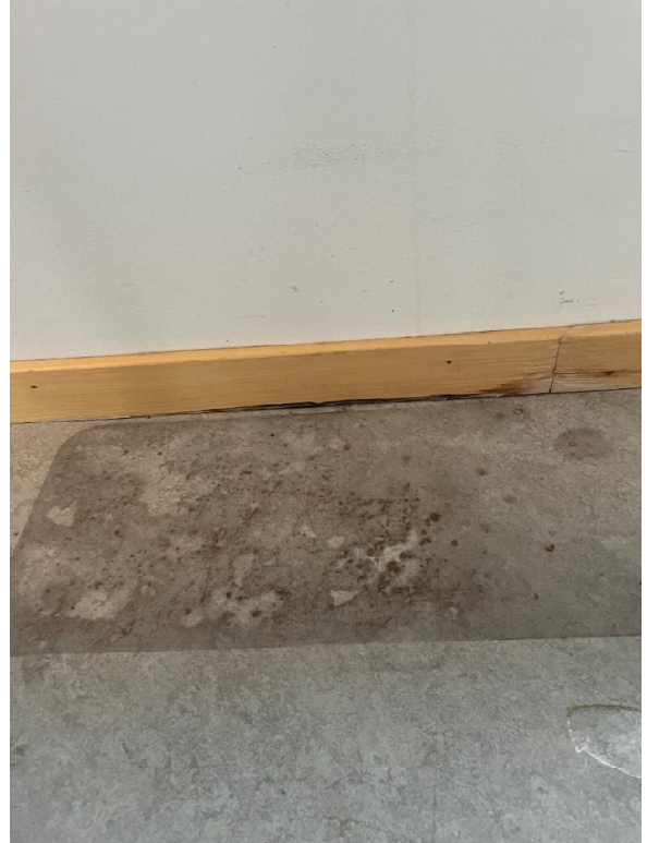
Figur 6, Golv i rund länkbyggnad, yttervägg.
