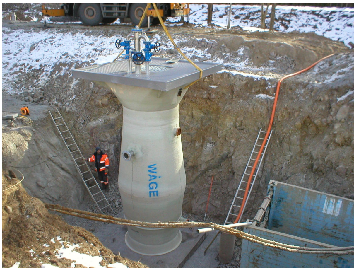
Pumpstationen vid Lundby backgård monteras
