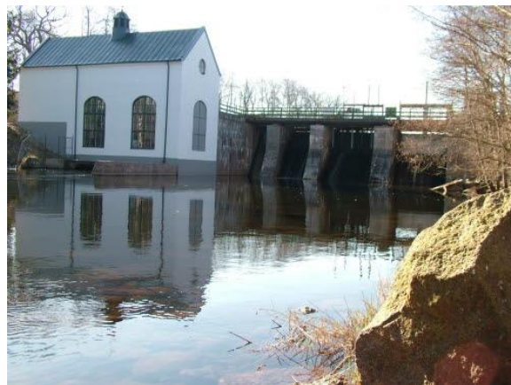
Kraftstationen i Flemminge
