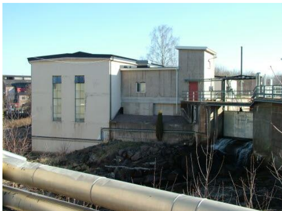
Kraftstationen i Bruksfallet
