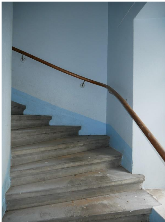
Svängd gjuten trappa med handledare från staden. Fönsterbågar i original med spår för avrinning.
