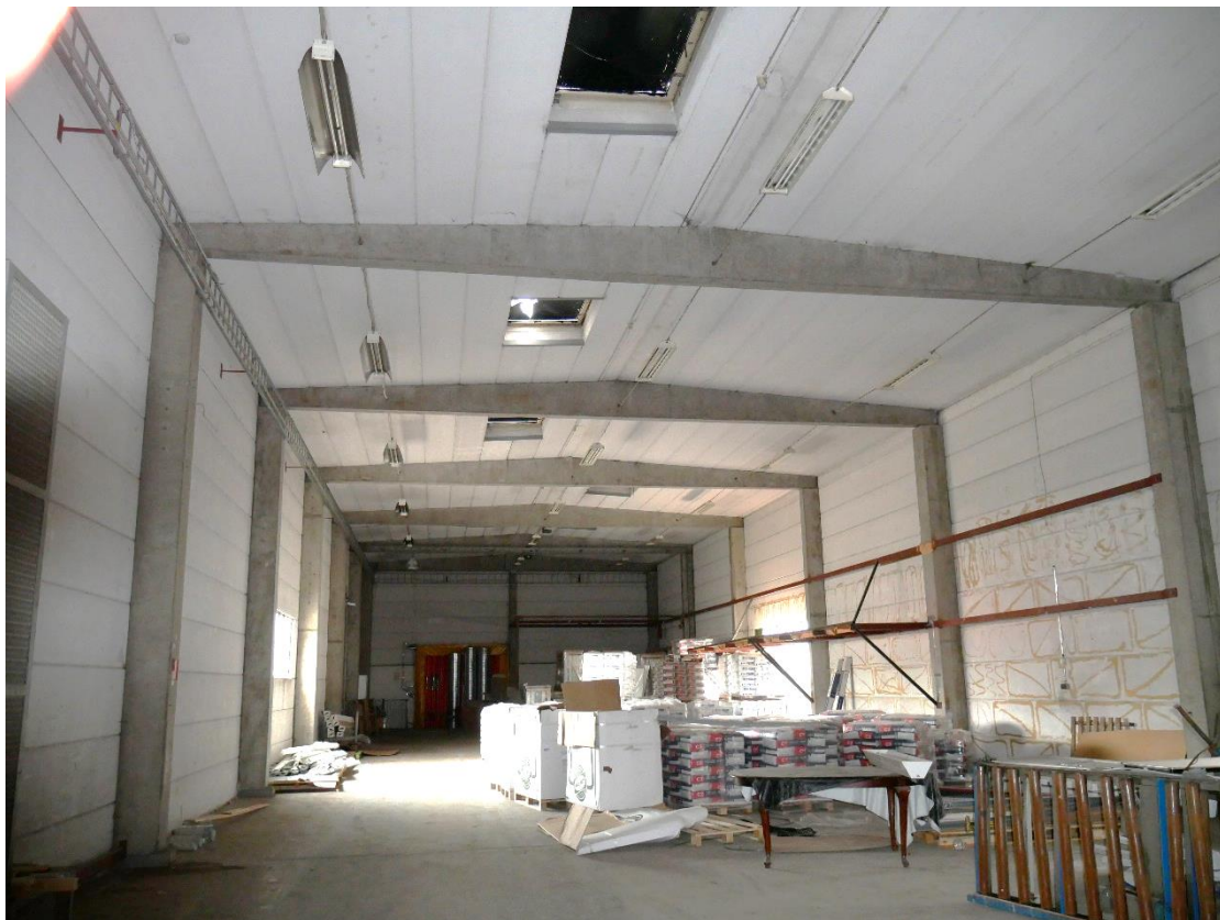
Byggelementen i konstruktionen är synliga.
