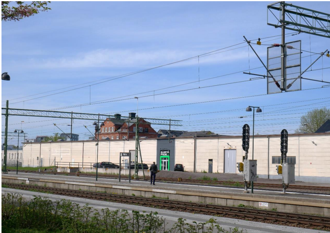
Lagerdelen från 1970-talets slut och början av 1980-talet. Byggnaden uppfattas som en mur som skiljer staden från järnvägen.
