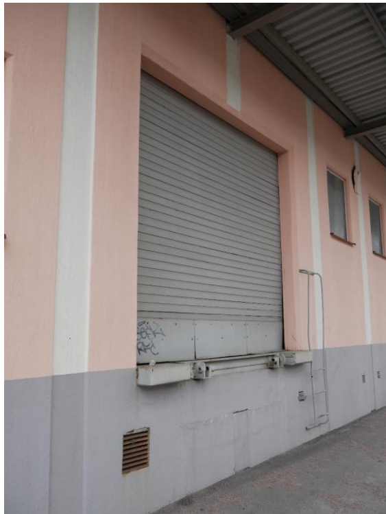
Lastlucka mot Magasinsgatan.
