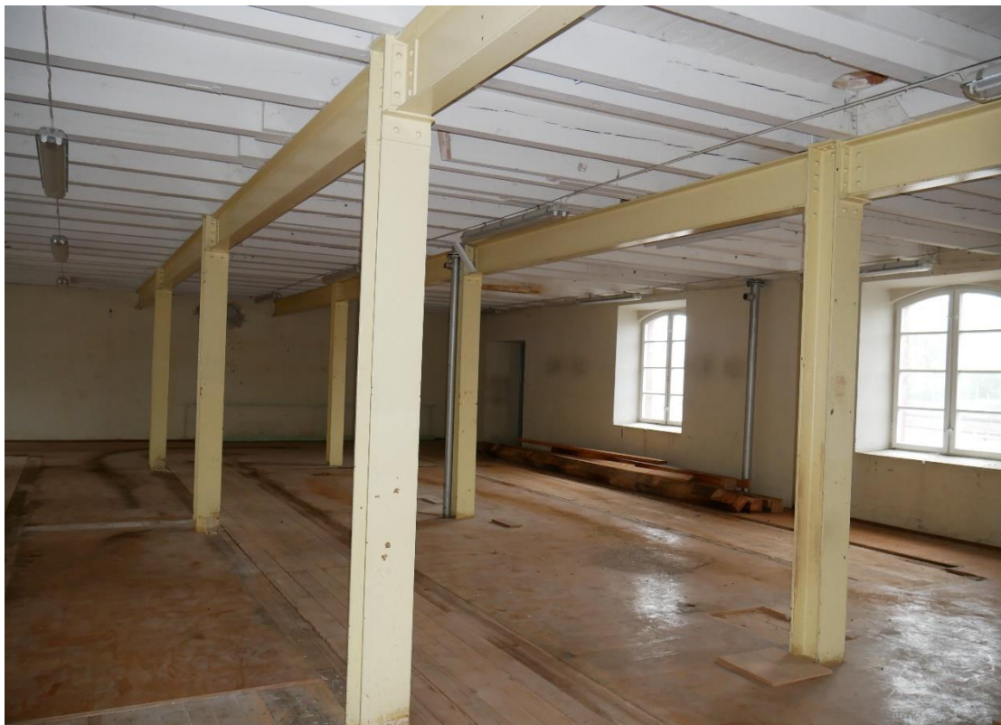
Järnbalkar i bjälklag och som stöd i kvarndelen. På golvet finns spår efter där maskinerna har stått.
