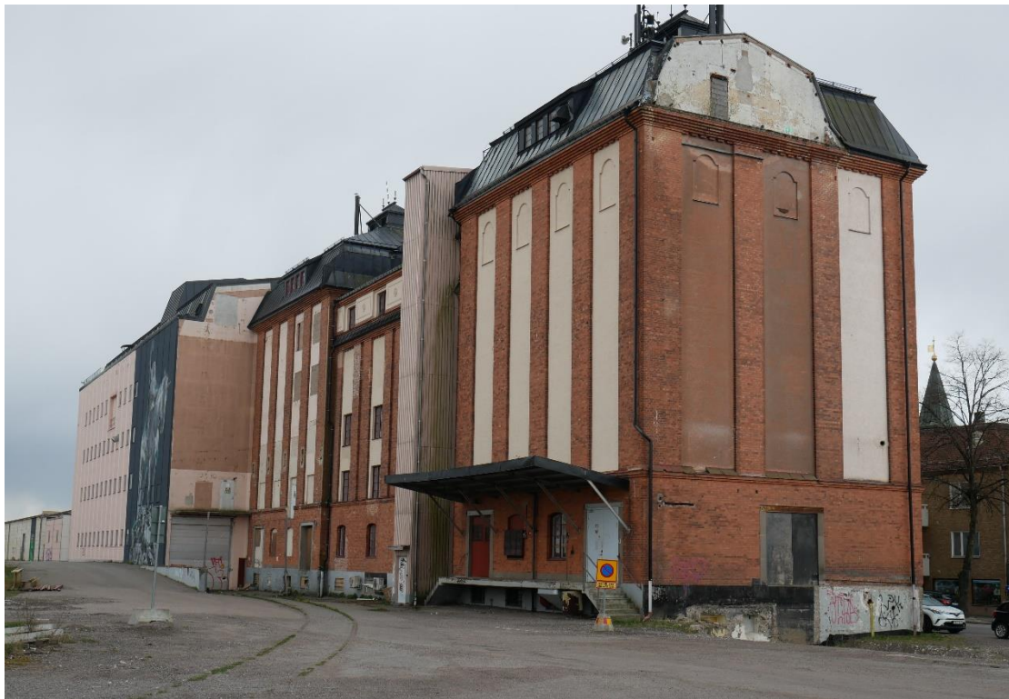
Stickspår intill mjölsilon. Gamla kvarnen har en utvändig hiss och en lastbrygga i silodelen som skyddas av ett skärmtak.
