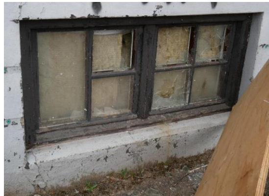
Även källarfönster är bevarade med originalbågar.
