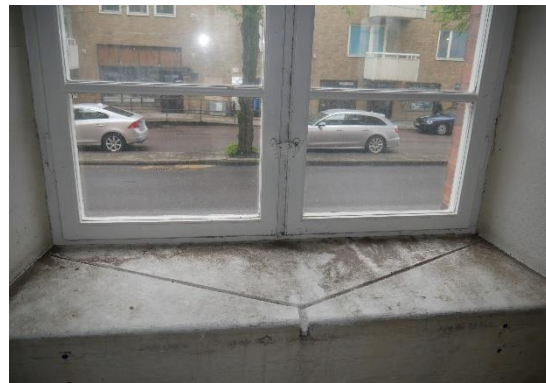
Svängd gjuten trappa med handledare från staden. Fönsterbågar i original med spår för avrinning.
