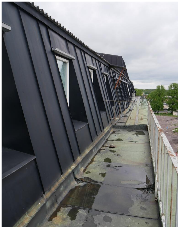
Balkong på femte våningen med koppjarplåt.
