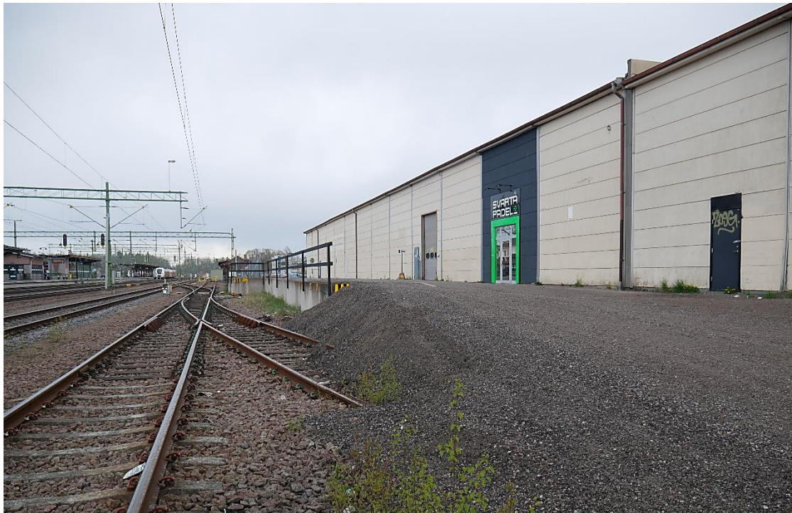
Den äldsta längan är från 1970-talet, avslutades med en vägg som syns som en kant över taklinjen. Lastbrygga i betong med räcken. Stickspåret fortsätter in mot gamla kvarnen.
