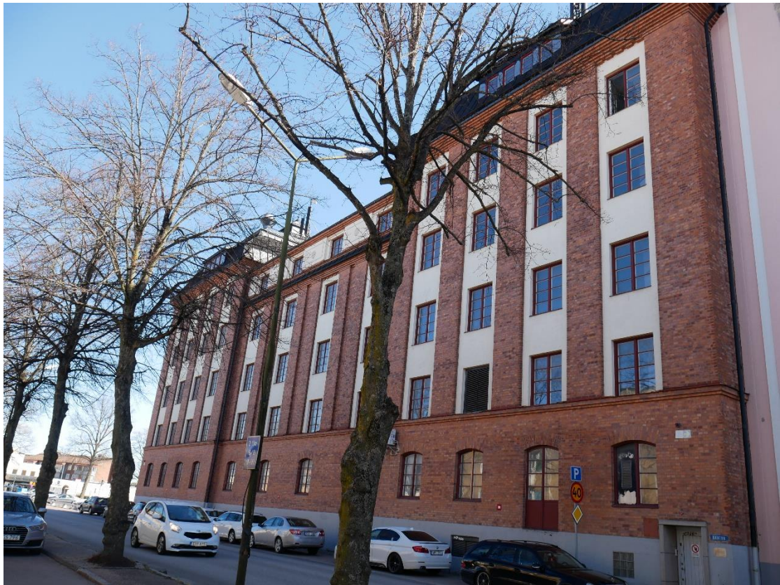
Kvarnbyggnaden från 1928 ut mot Magasinsgatan.
