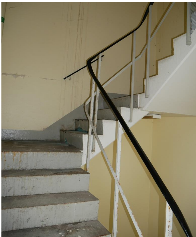
Smal trappa med gjutna steg.
