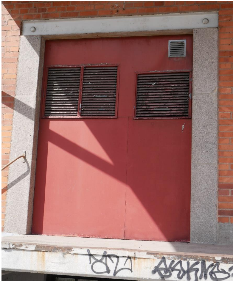
Portar vid lastbryggorna har omfattningar av hamrad granit.
