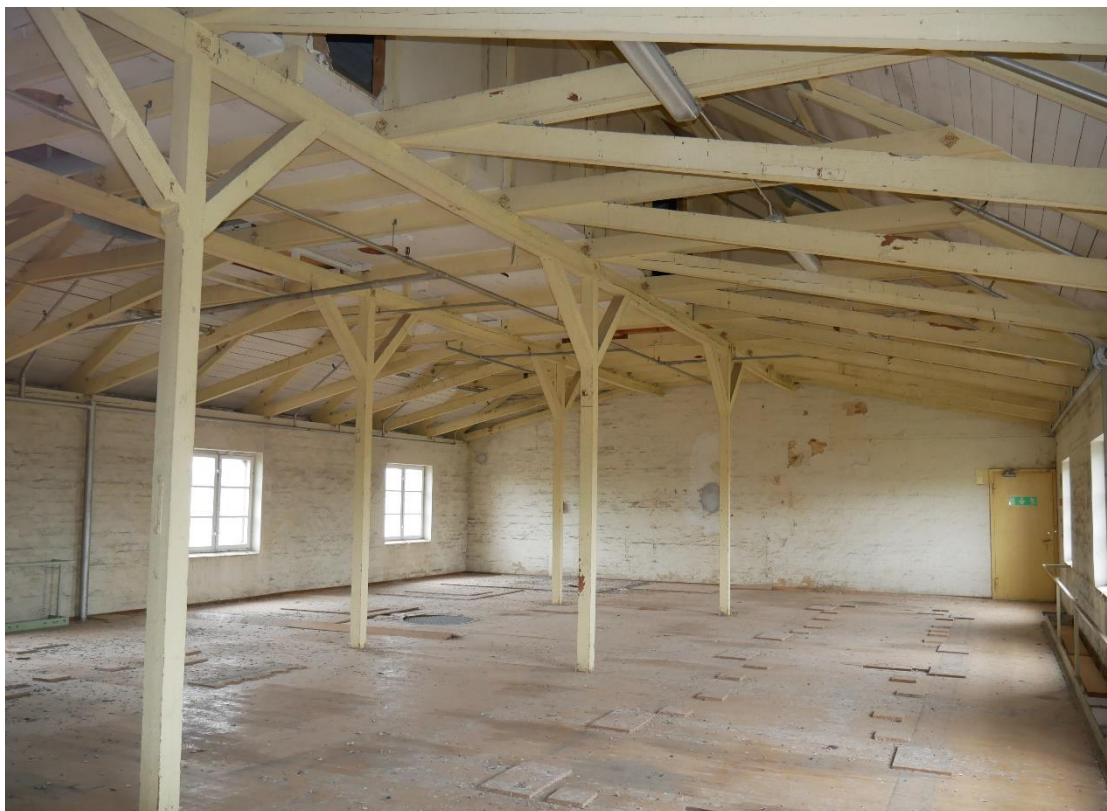
Vindsvåning med träbjälkar.
