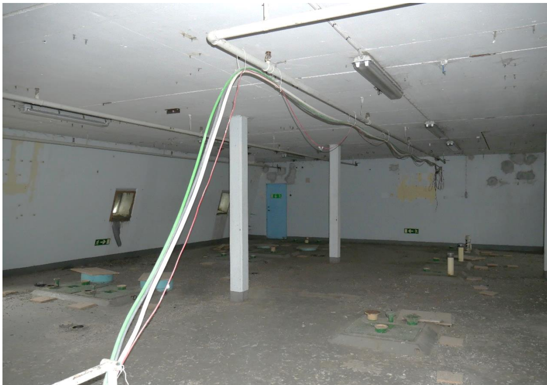
Tak, väggar golv och pelare är gjutna. Endast små fönsteröppningar släpper in ljus.
