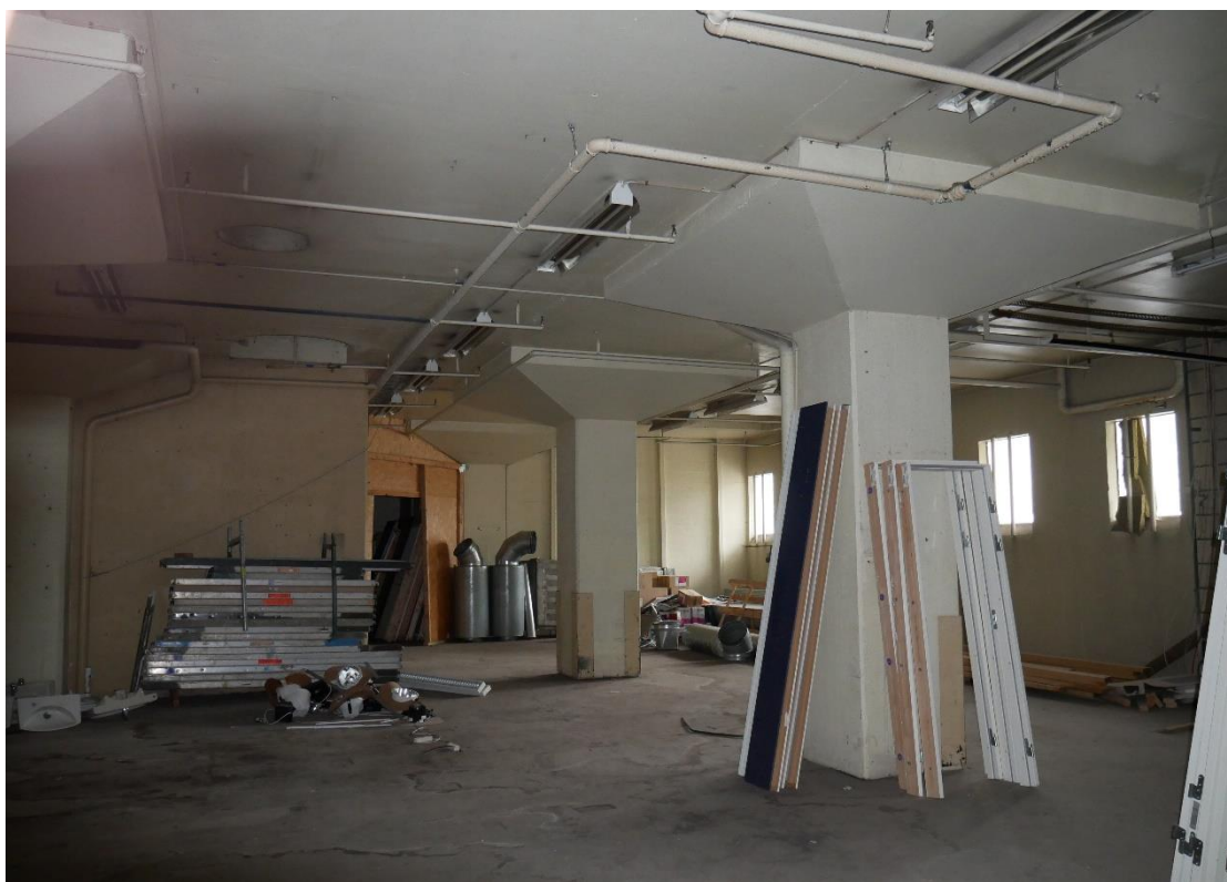
Källaren med gjutna stöd.
