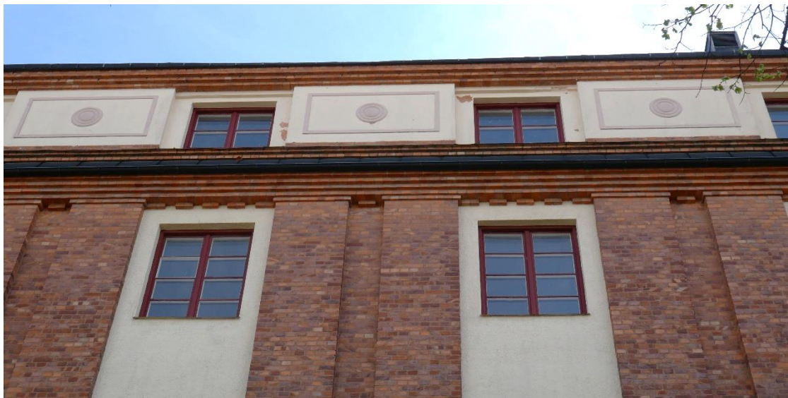
Dekorativa element i fasaden som har stort arkitektoniskt värde.
