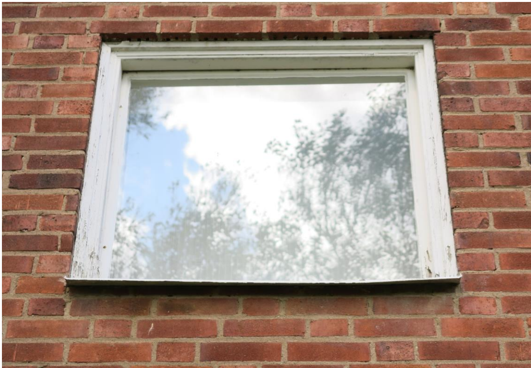
Värdebärande karaktärsdrag: Ospröjsade fönster i trä.
