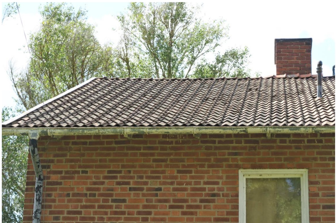
Värdebärande karaktärsdrag: Brant sadeltak med tvåkupigt taktegel samt murad skorsten.
