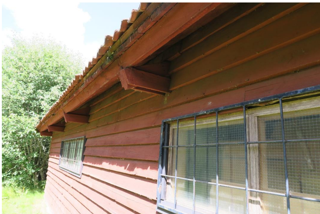
Moderna fönster (liknande fönsterband) med galler.
