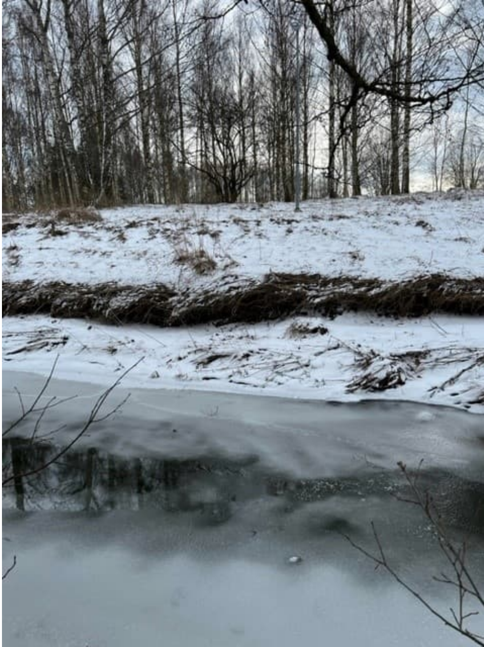
Figur 12. Fotografi taget från den norra sidan där tecken på viss erosion kan skimras på den södra sidan av Skenaån.
