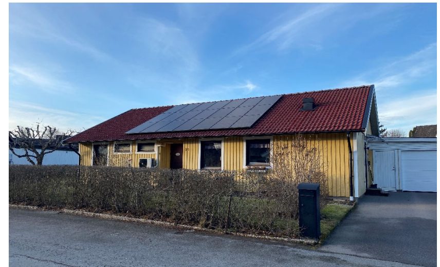
En sammanhållen yta av paneler med synligt tak runt om då endast en del av takytan täcks.
