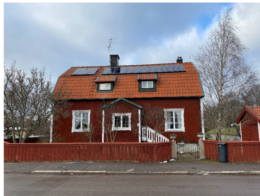
Solceller i två sammanhållna rektangulära ytor som bryts av en stega.
