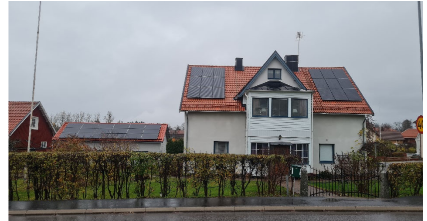
Flera paneler på samma takfall. Notera att även komplementbyggnader kan ha solcellspaneler.
