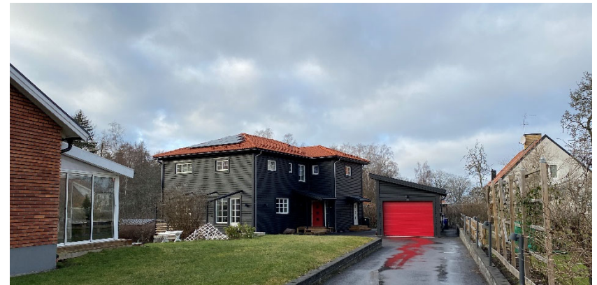
Trappstegsmonterade solceller i en sammanhållen yta på valmat tak.
