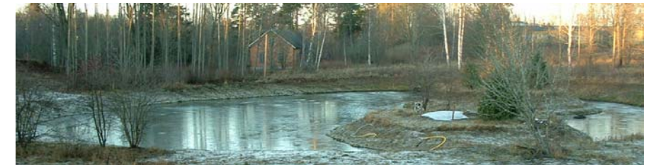
Dagvattenmagasin söder om lokstallar.
