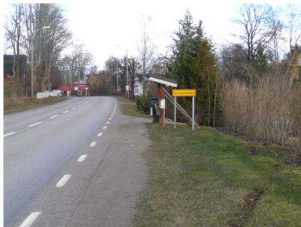
Bildtext: Väg 942 norr om planområdet och vägslänt söder om väg 942.
