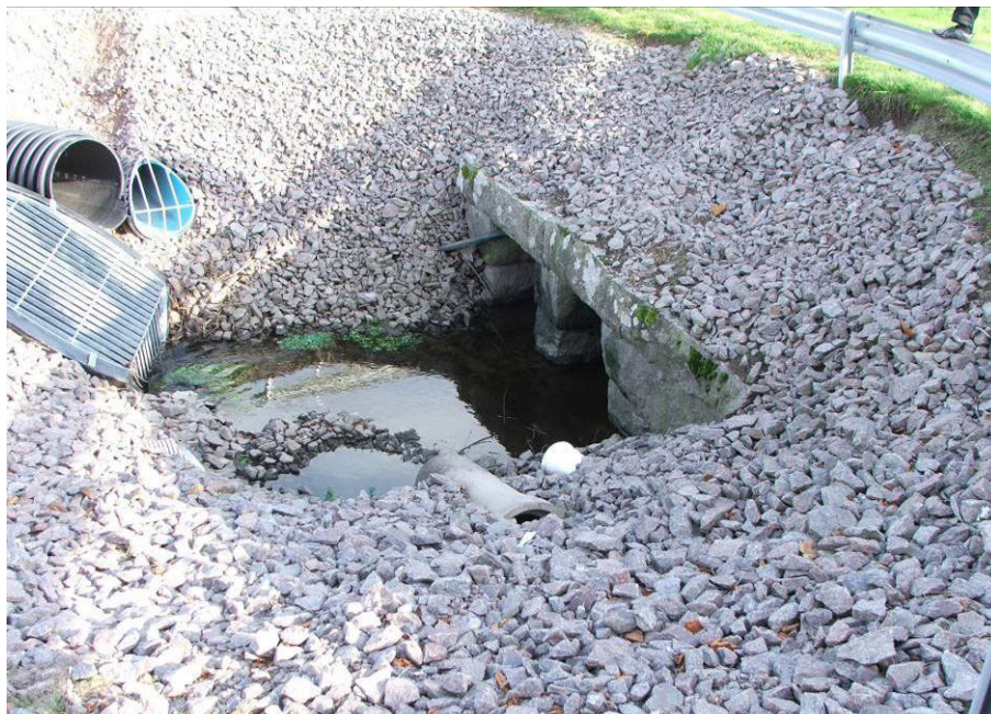
Figur 3.15.1. Vid Väderstadverken. Från vänster: utgående 1800 mm kulvert, utgående 800 mm bräddavlopp (byggt 2008), inkommande dagvattenledning, stensatt trumma under Folkungavägen-Hogstadvägen, 2008-10-03. Foto: Sweco
