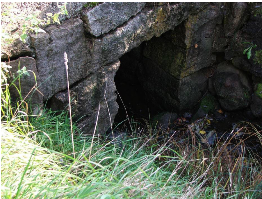
Figur 3.8.1. Inlopp till stensatt kulvert under Vallsbergsvägen, 2008-10-03. Foto: Sweco
