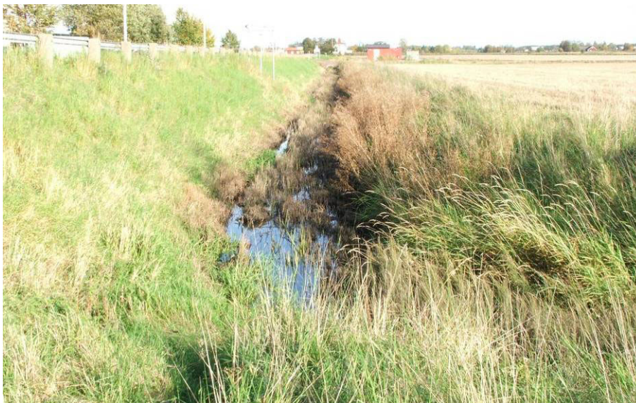
Figur 3.11.1. Vy nedströms mot Surbo avloppspumpstation, 2008-10-03. Foto: Sweco
