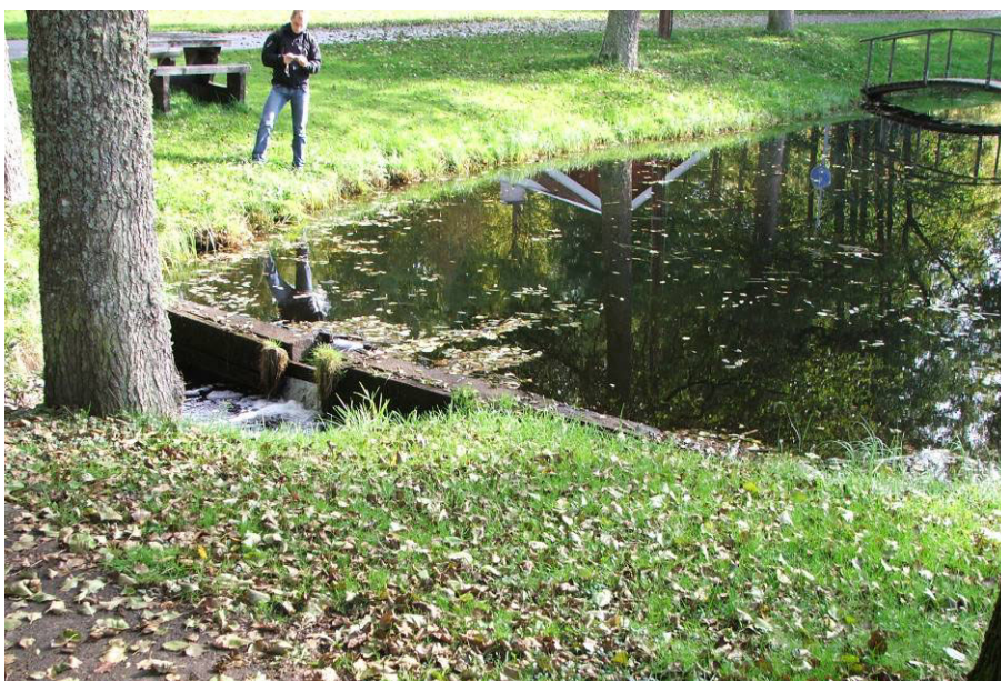
Figur 4.2.2. Dämme vid hembygdsgården, 2008-10-03. Foto: Sweco
