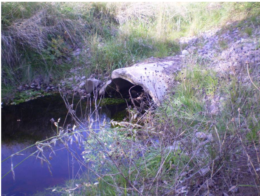
Figur 3.2.1. Inlopp till trumma under gamla E4, 2008-10-03. Foto: Sweco
