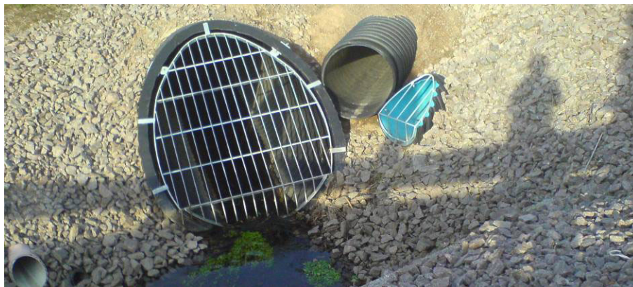
Figur 3.16.1. Vid Väderstadverken. Från vänster: utgående 1800 mm kulvert, utgående 800 mm bräddavlopp (byggt 2008), inkommande dagvattenledning 2008-10-03. Foto: Sweco
