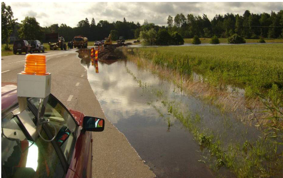
Figur 3.2.2. Tillfällig skyddsfördämning vid trumman under gamla E4, 2007-07-10. Foto: Mjölby kommun.
