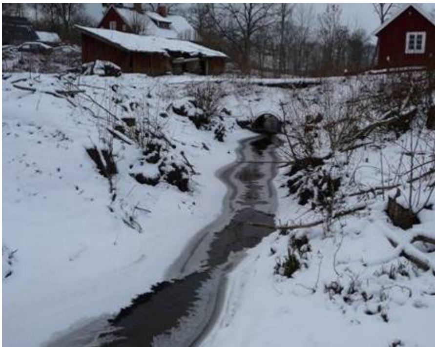
Figur 3.6.1. Vy uppströms mot vägtrumma vid Boberg, 2009-02-10. Foto: Mjölby kommun.
