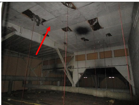
Mineralskivor på vind med asbestinnehåll
