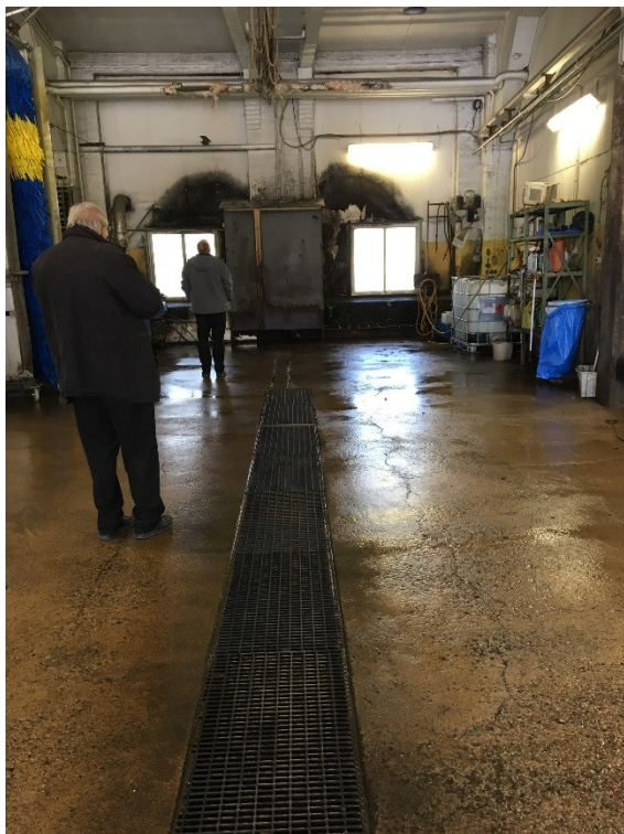
Figur 8. Spolplatta med uppsamling av tvättvatten i mittrännan.
