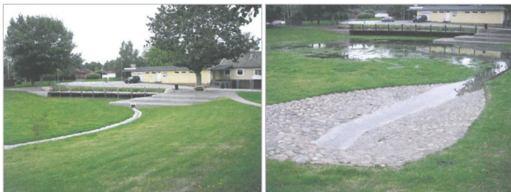
Figur 40. Öppet fördröjningsmagasin, tomt till vänster och med vattenspegel till höger (Publikation P105).
