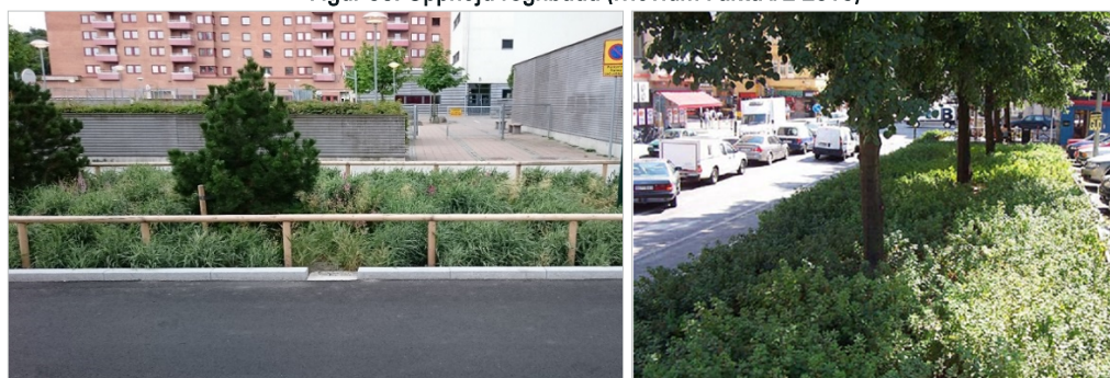
Figur 37. Till vänster, nedsänkt regnbädd med inlopp genom nedsänkt kantsten. (sigmacivil.se). Till höger, regnbädd med trädplantering i anslutning till parkering, foto: Björn Embrèn.
