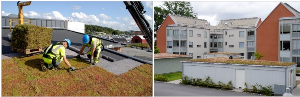
Figur 33. Anläggning av gröna tak till vänster och färdigt tak på miljörum till höger, bilder från vegtech.se.
