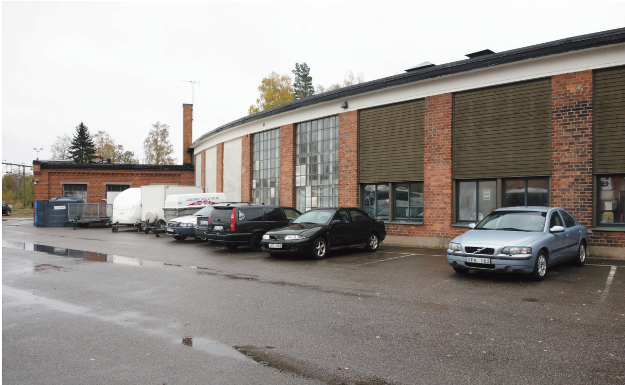
Fasad mot norr. Notera konsolfrisen i takfot på den lägre byggnadskroppen till vänster. Två ursprungliga fönster finns mot norr.
