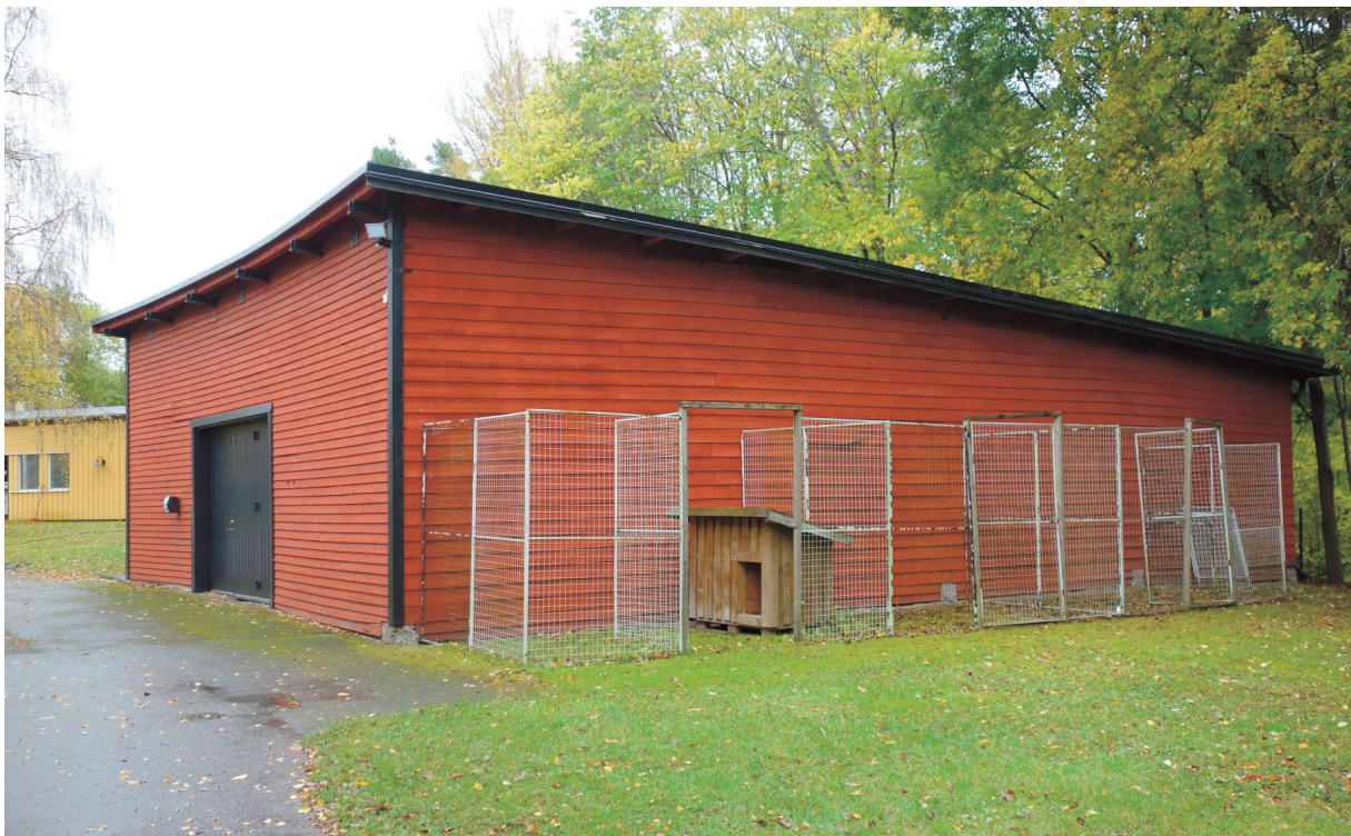
Förrådsbyggnad söder om lokstallet med takkonstruktion av järnvägsräls.
