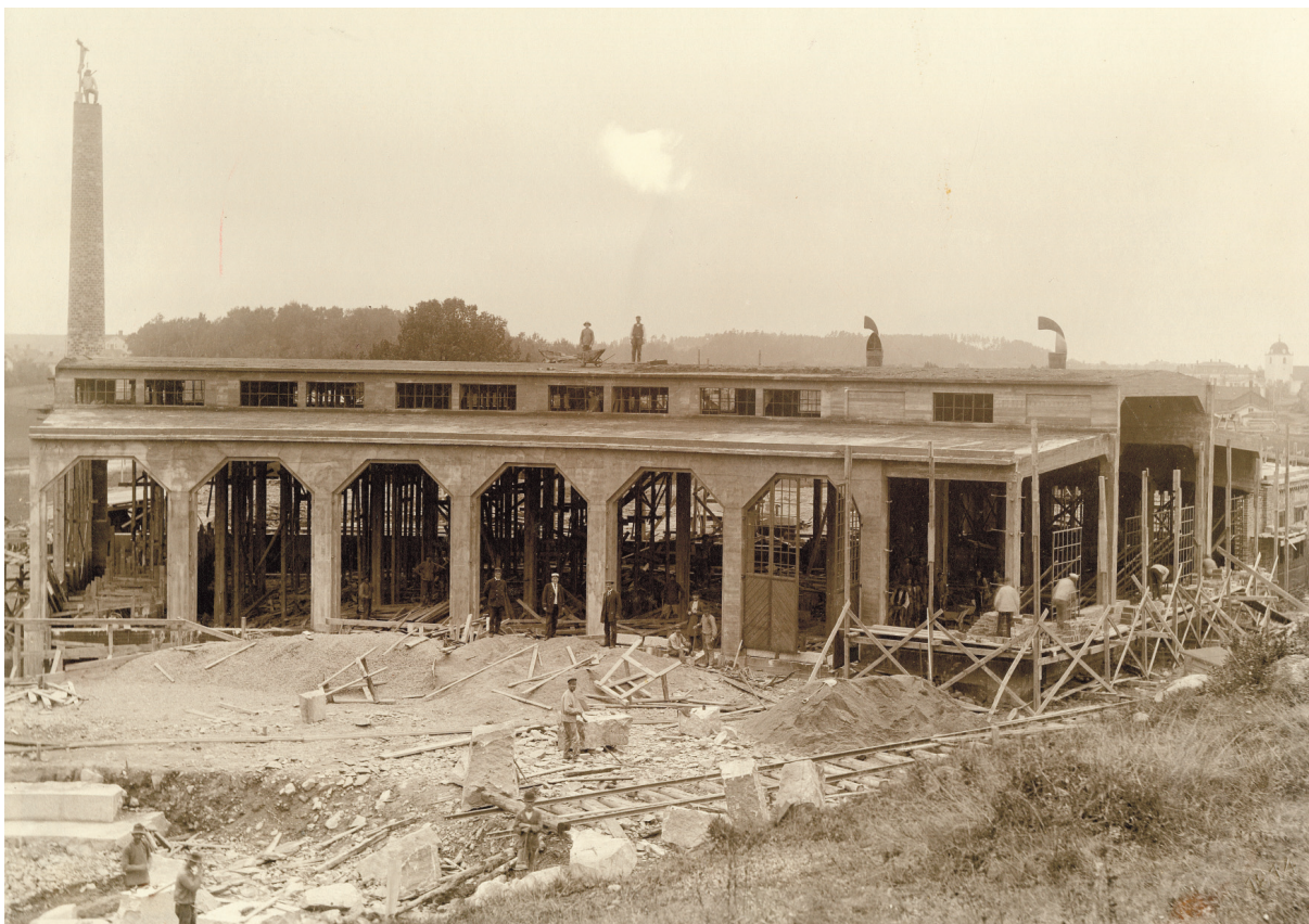
Det nya lokstallet under uppbyggnad 1915 (Samlingsportalen/ Digitalt museum).
