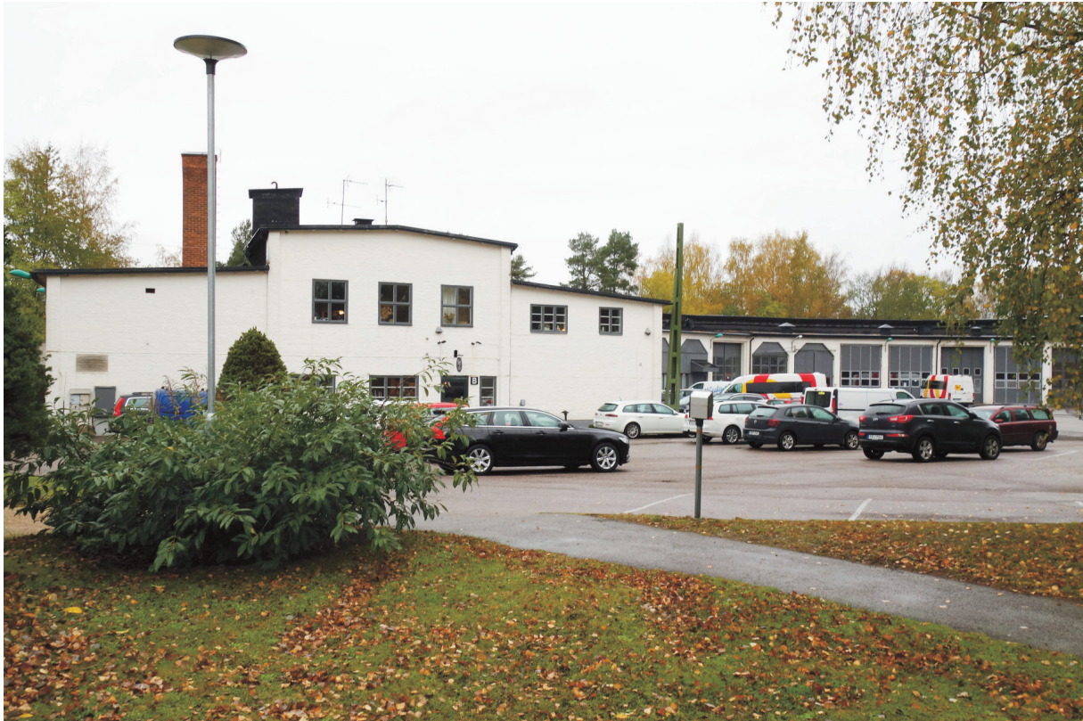
Den södra gaveln mot öster har målats vit till skillnad mot den norra som ännu har synlig tegelfasad.
