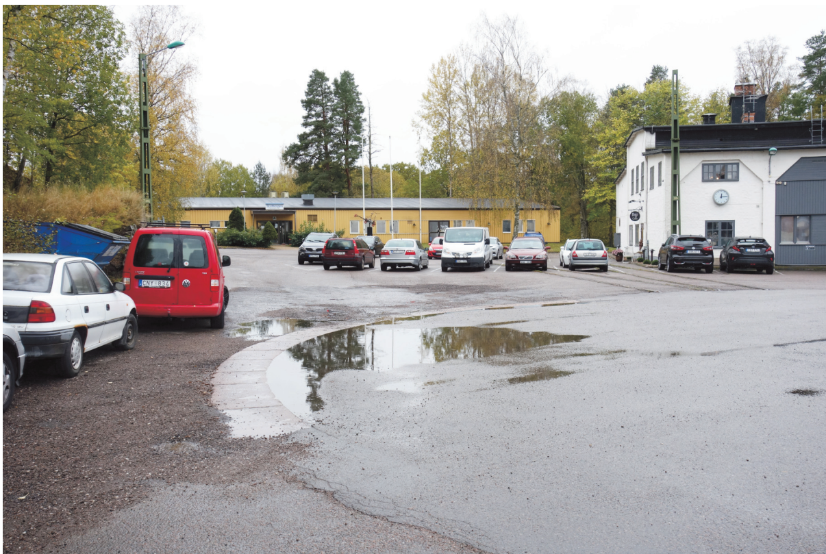
Lokbangården mot söder med en gul låg kontorsbyggnad i bakgrunden. I förgrunden syns den granitram som markerar den tidigare vändskivan.
