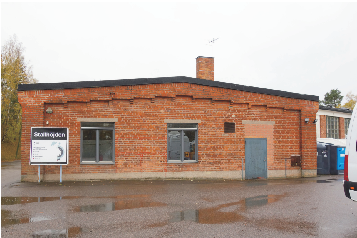
Tegelfasad mot norr med murade pilastrar och takfris.
