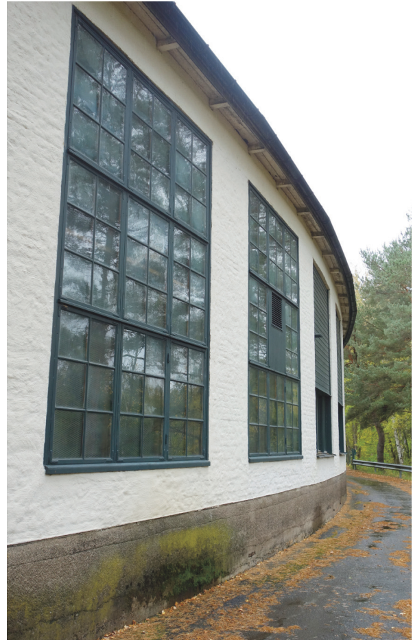
Ursprungliga småspröjsade fönsterpartier mot väster.
