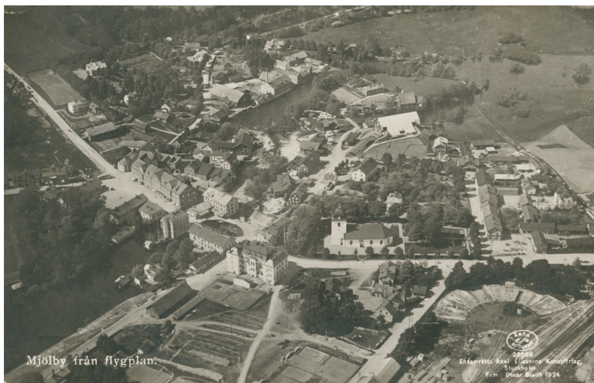
Det första lokstallet var placerat strax sydöst om kyrkan. Lokstallet revs 1922 och fotografiet från 1924 visar byggnadens grund som då ännu fanns kvar. Senare uppfördes silor tillhörande kvarnindustrin på platsen (Samlingsportalen/Digitalt museum).
