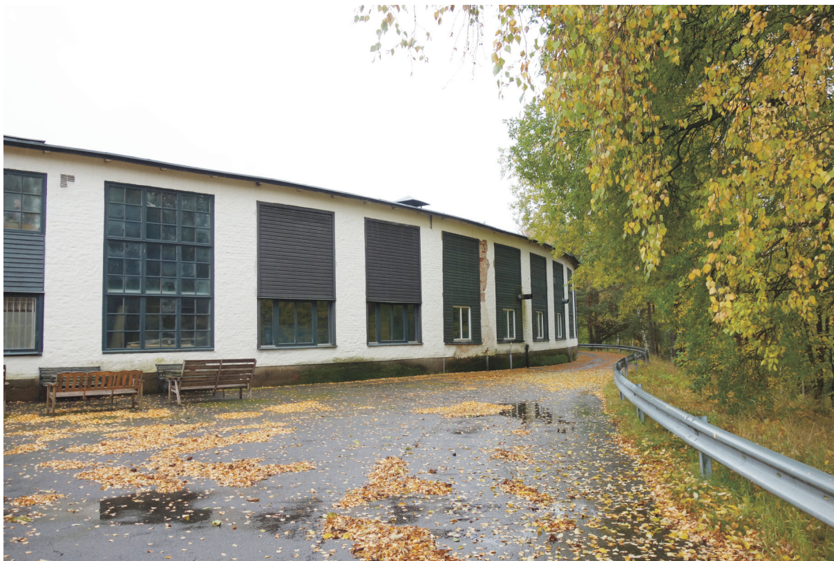
Enstaka ursprungliga fönster finns i fasad mot väster.
