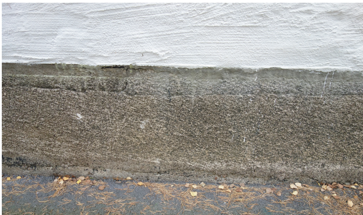
Betongsockeln har behandlats för att få ett utseende likt krysshamrad granit.
