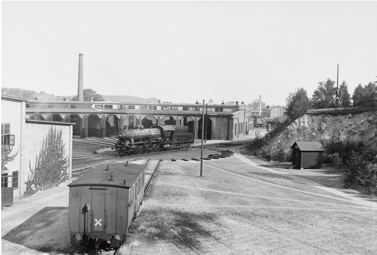
Det fullt utbyggda lokstallet 1930. Notera de småspröjsade fönstren i mezzaninvåningen (Samlingsportalen/ Digitalt museum).
