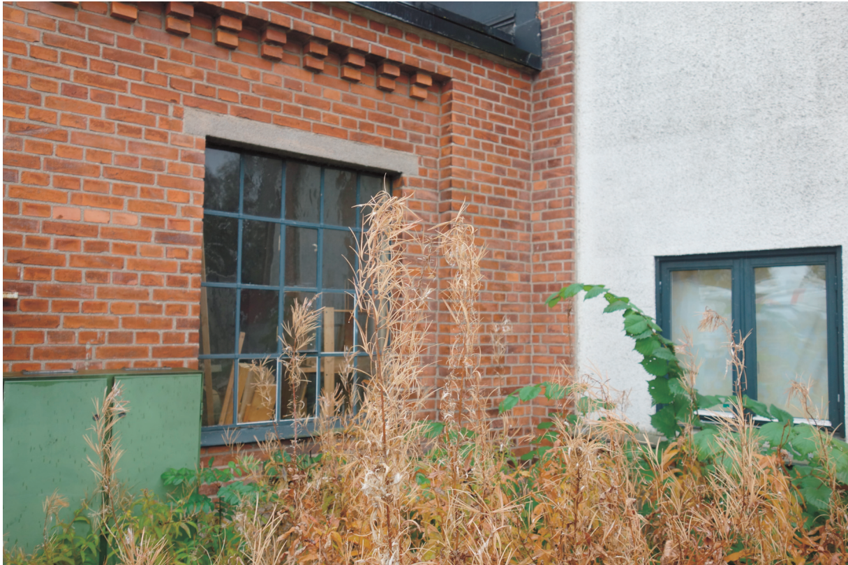
Karaktäristisk konsolfris och ursprungliga småspröjsade fönster utgör värdebärande delar som bör värnas.
