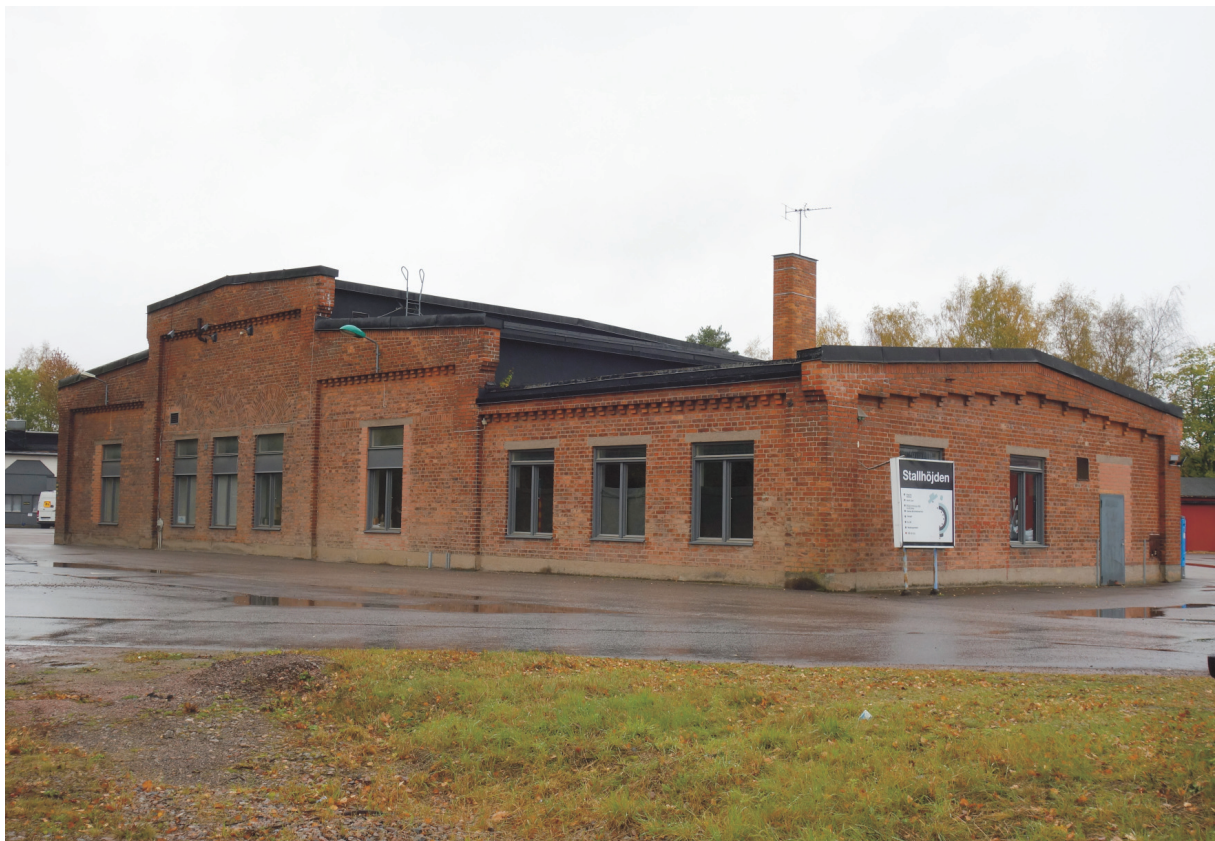
I norr och nordöst har de ursprungliga tegelfasaderna bevarats.
