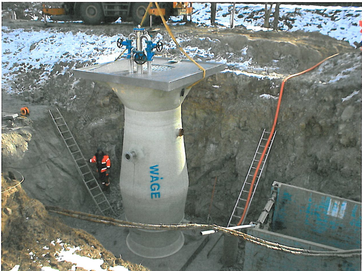
Pumpstationen vid Lundby backgård monteras
