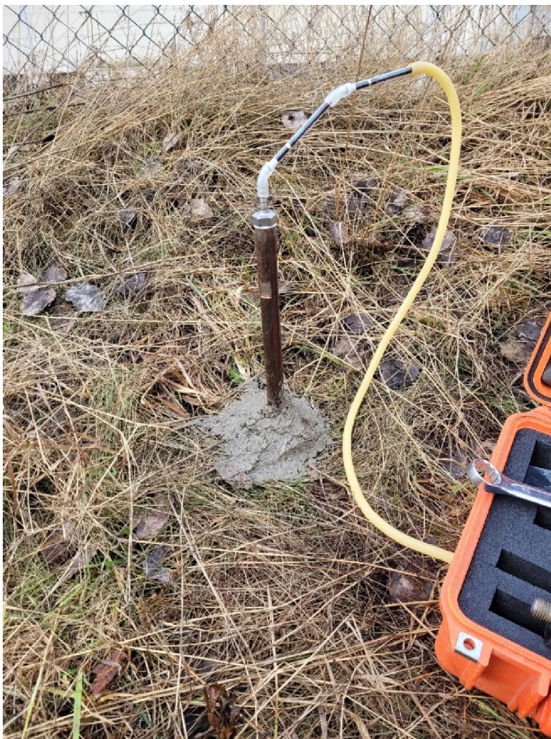
Figur 12. Fotot visar installerat jordspjut ihopkopplat med adsorbetrör och pump i provpunkt 25T611.
