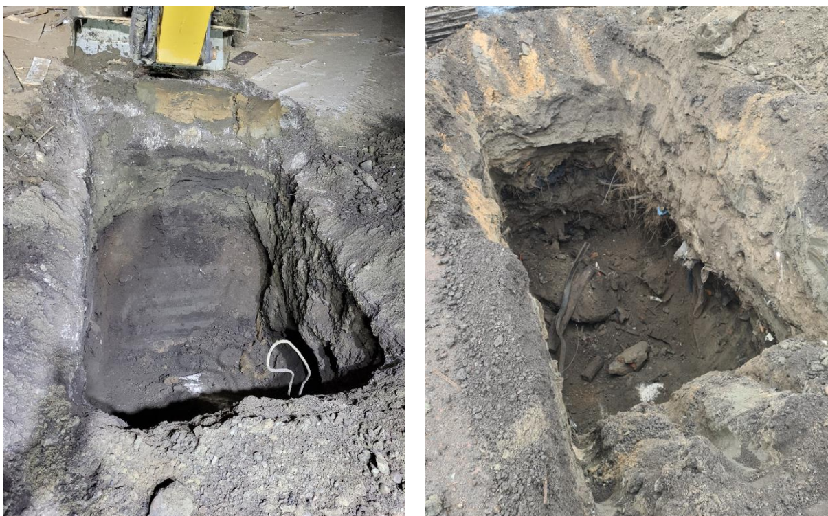
Figur 8. Exempel på provgropar med lägre andel deponerat material. 23T306 till vänster (betong skymtar i botten och sladd ytligt i provgropen) och PG7 till höger.
