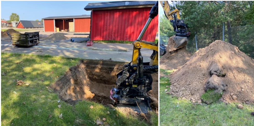
Figur 10. Provgropsgrävning i provpunkt 24TYSPOL03. Foto av Tyréns AB, 2024-08-29.
