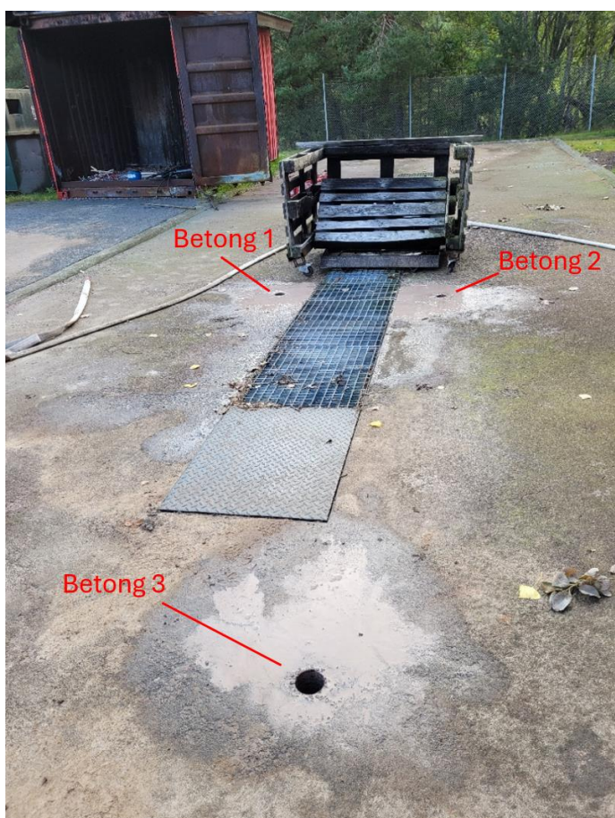
Figur 7. Översiktsfoto över de tre provpunkterna av betong i spolplattan. Längst upp i fotot syns lastpallar som släckning har övats på. Mellan provpunkterna är uppsamlingsrännan och uppsamlingsbrunnen. Norr är i riktning vänster vinkelrätt från uppsamlingsrännan. Foto: Tyréns AB, 2024-09-04.
