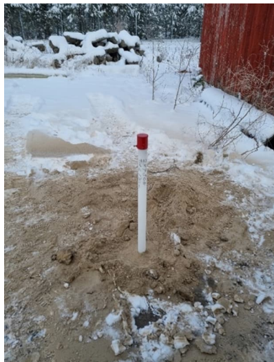
Figur 6. Grundvattenrör 23T508 efter installation på fastigheten Omlastaren 4
