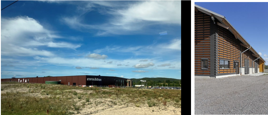
Bruna och gula fasader. Längst upp t.v. Martin & Serveras lager i Norrköping NCS 7020-Y80R (RAL 8016) (egen bild), längst upp t.h. Löhammar ladugård med atracitgrå och okrafärgad fasad (malmstromedstrom.se, u.d.).
